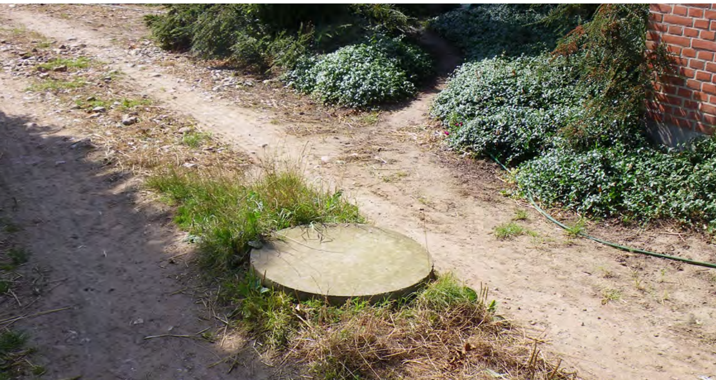
Uheldig placering af husholdningsboring midt i indkørsel. Foto: Kolding Kommune.
