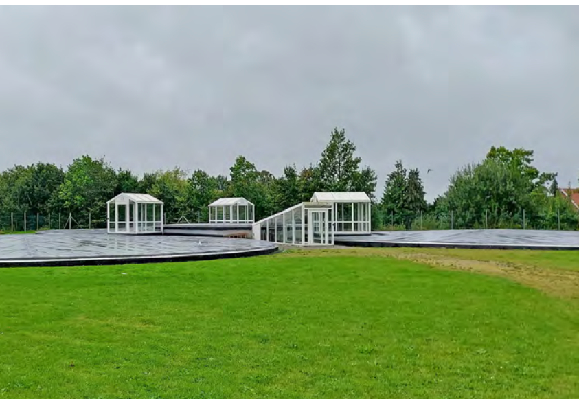
TREFOR Vands beholderanlæg på Norgesvej. Foto: Kolding Kommune.
