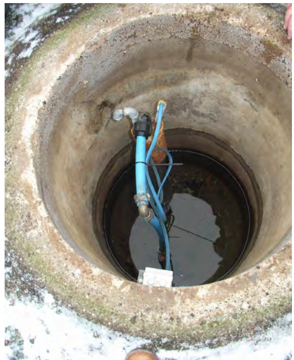
Tørbrønd ved husholdningsboring med vand i bunden Foto: Kolding Kommune.
