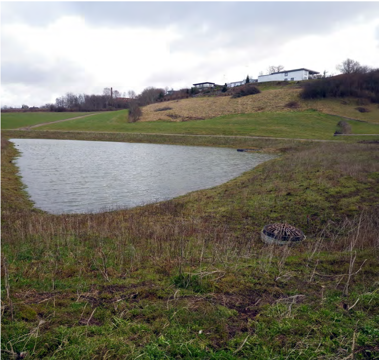
Regnvandsbassin i Kolding Nord. Foto: Kolding Kommune.
