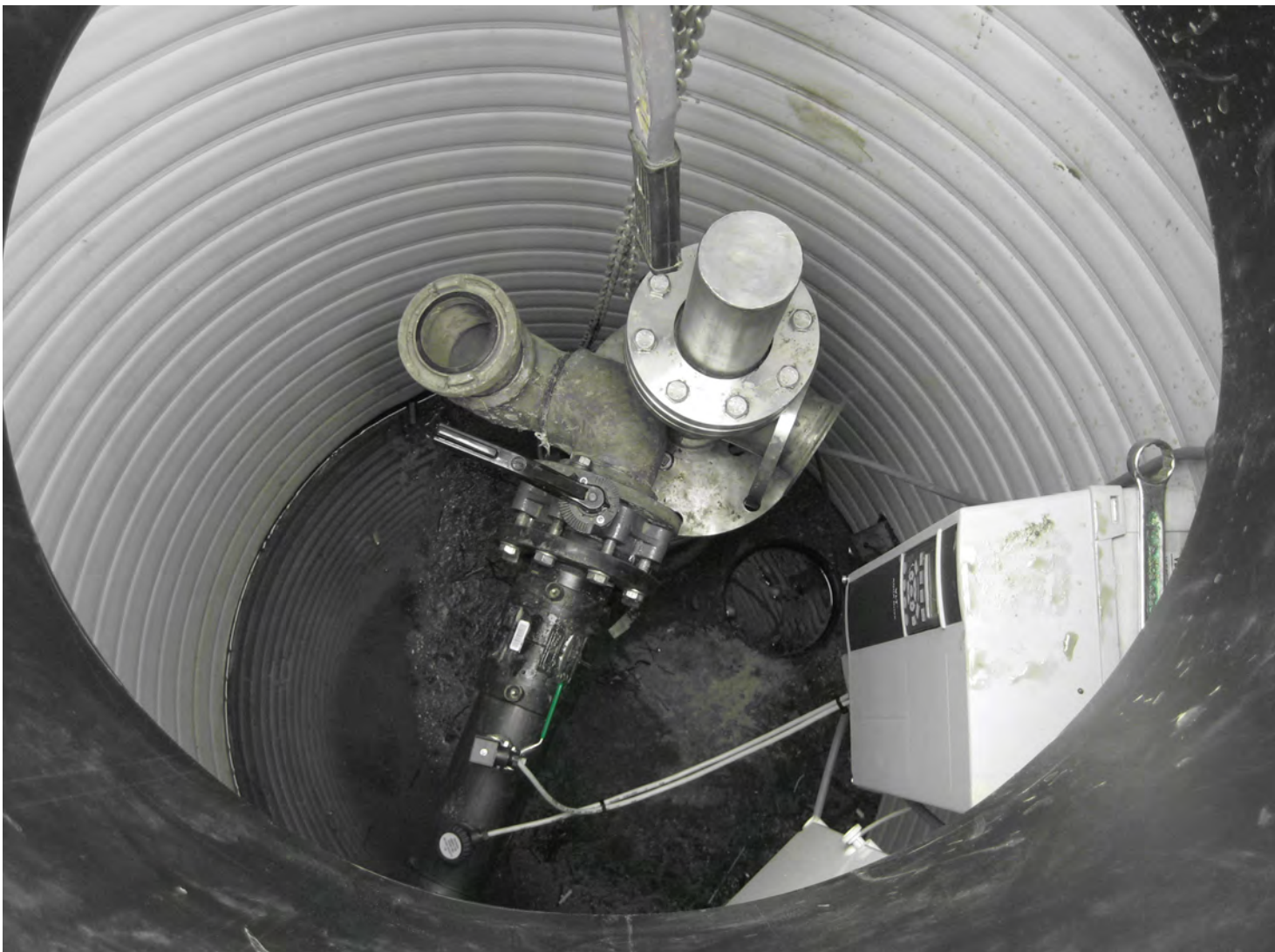
ATES-boring ved SDU, Kolding. Foto: Kolding Kommune.
