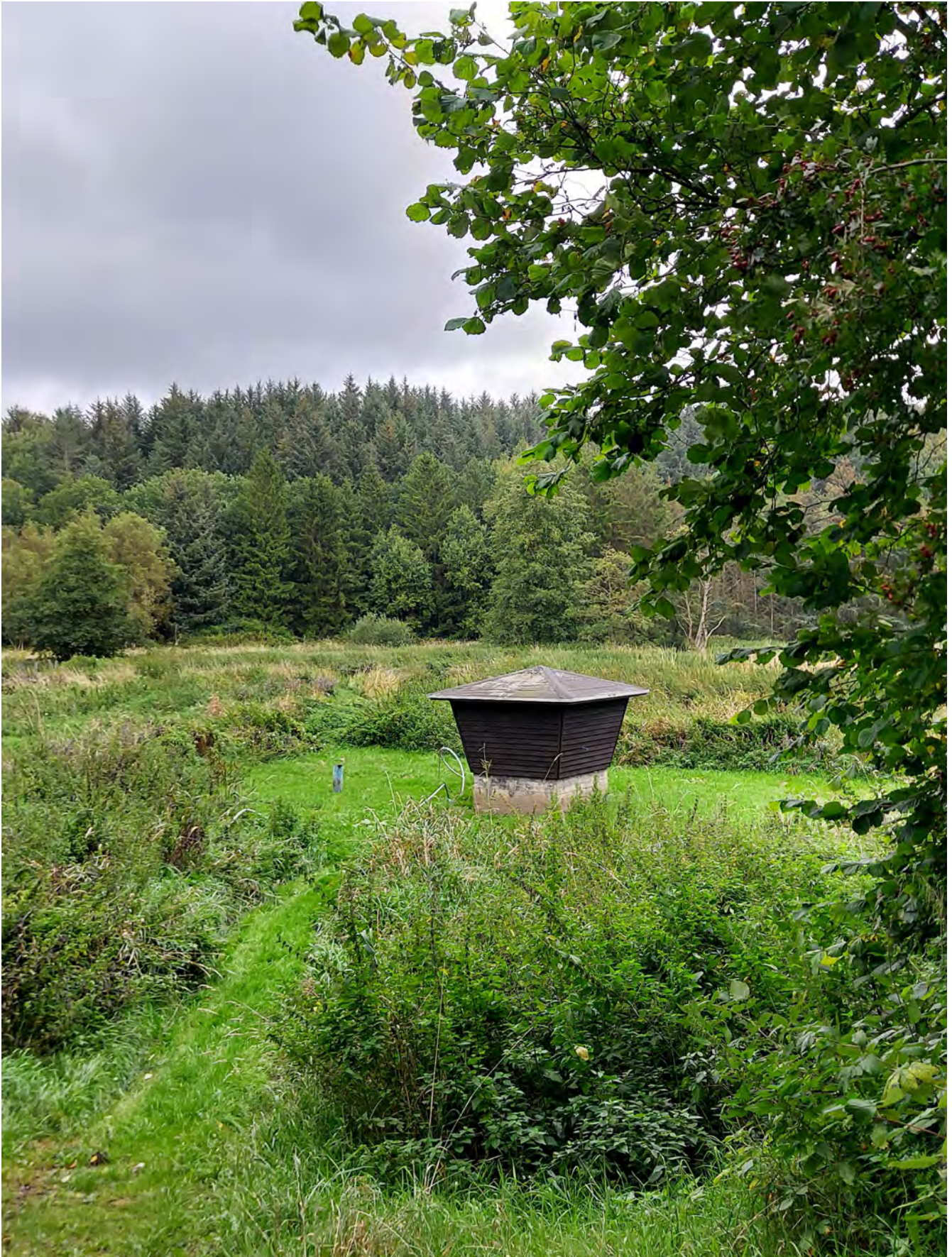
Råvandsstation - Trudsbro Vandværk (TREFOR Vand). Foto: Kolding Kommune.
