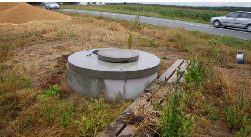
Markvandingsboring – tørbrønd. Foto: Kolding Kommune.
