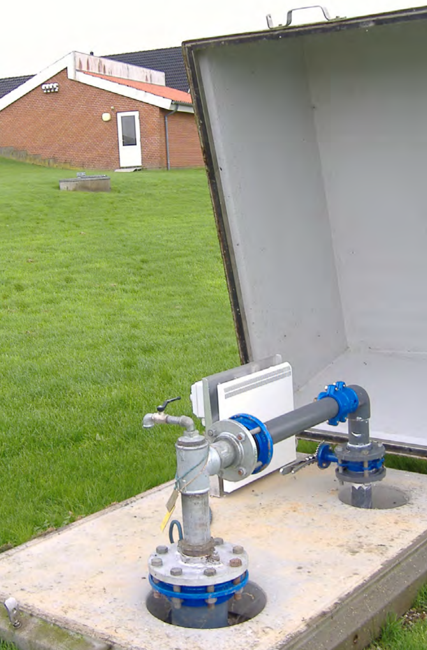
Terrænliggende boring ved Ødis Vandværk. Foto: Kolding Kommune.
