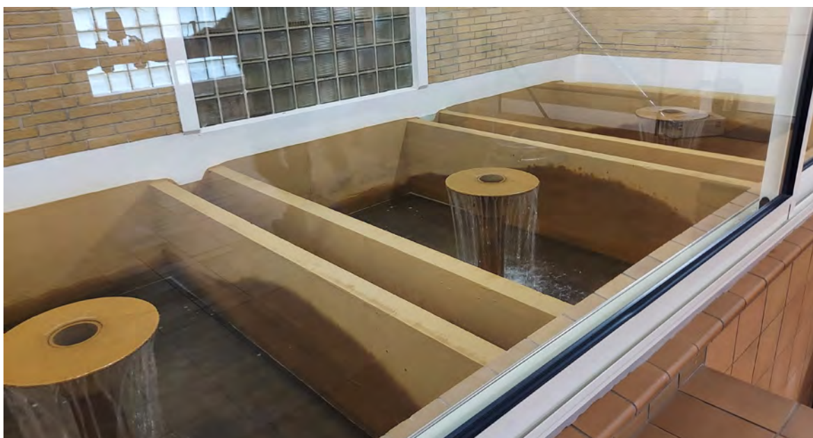
Åbne sandfiltre på Sønderholm, Bramdrupdam Vandværk. Foto: Kolding Kommune.
