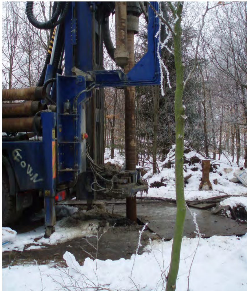
Etablering af ny boring til Vonsild Vandværk. Foto: Kolding Kommune.
