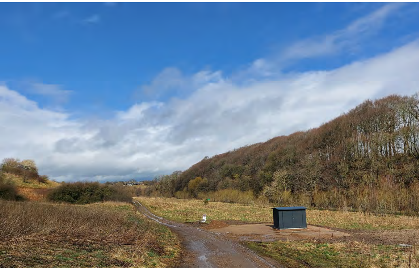
Råvandsstation på kildepladsen til TREFOR Vand - Søndre Vandværk. Foto: Kolding Kommune.
